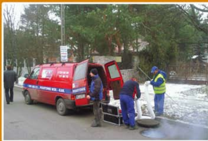
Prace w terenie
